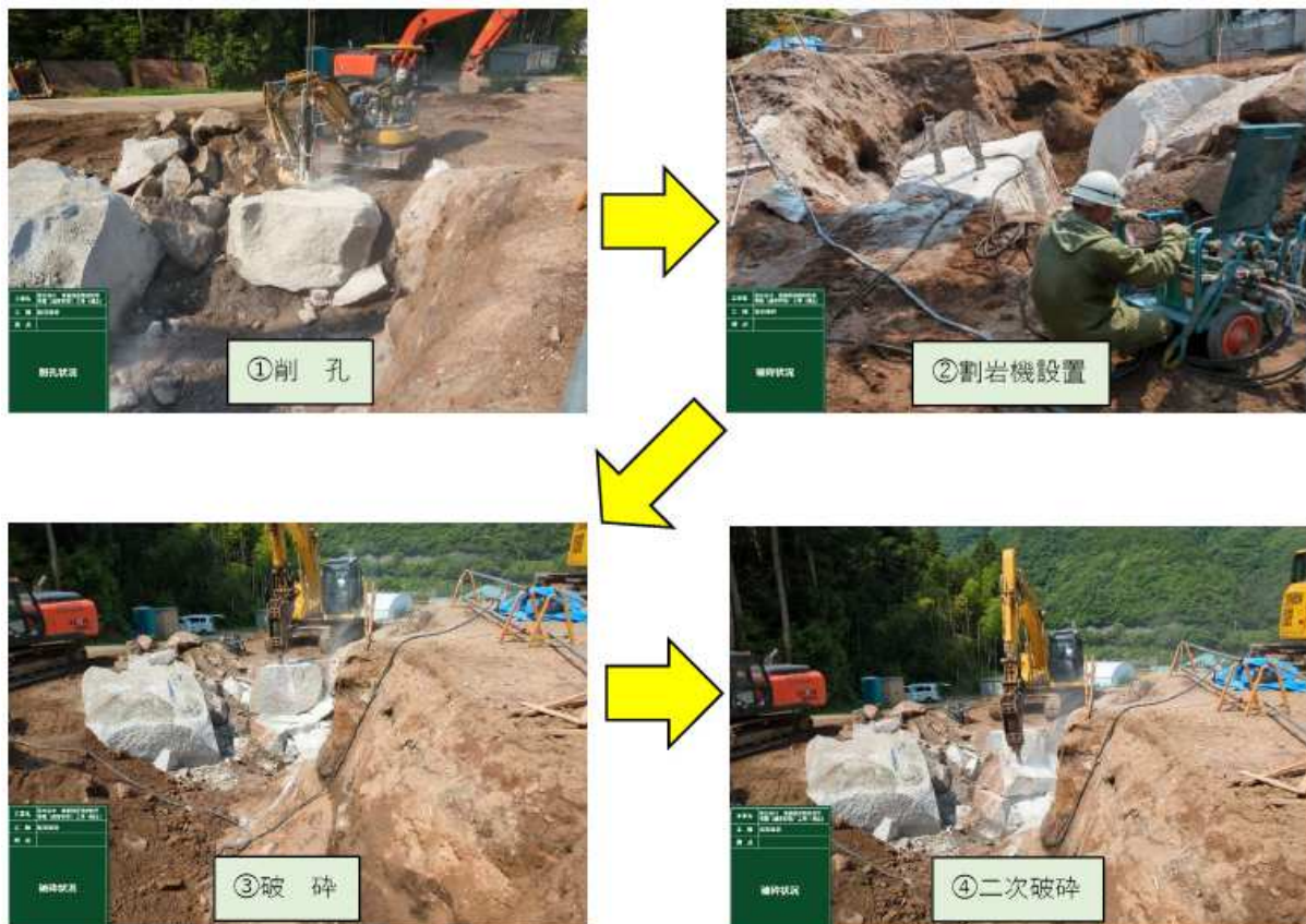
写真-4 施行状況写真
