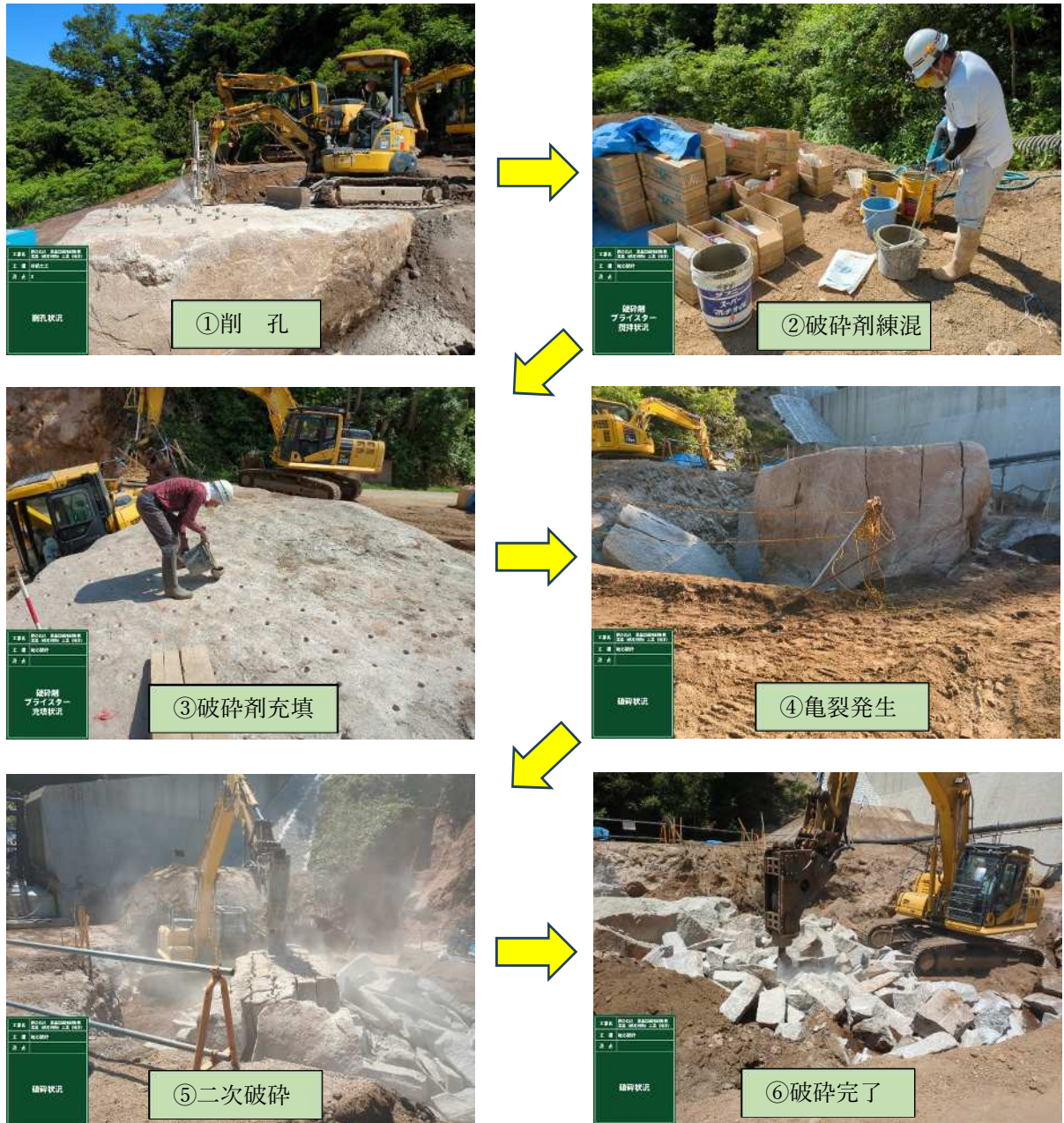
写真-3 施行状況写真
