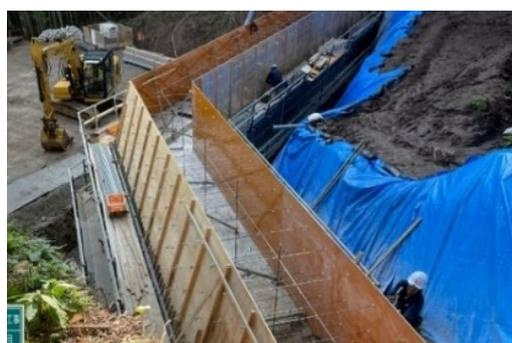
写真-1 県産ヒノキ合板型枠（溪間工）
