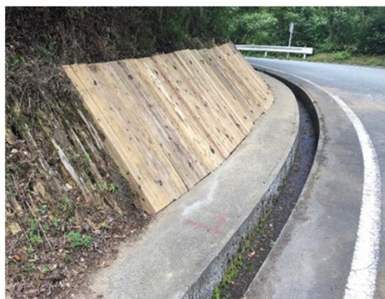
写真-7 パネル部分取替え箇所
