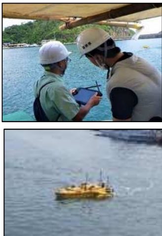
写真-4、5 ASV 操作状況
