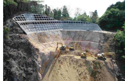
写真8 法柵工(逆巻施工)状況
