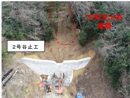
写真9 2号谷止工施工状況
