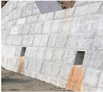
写真 11 残存化粧型枠施工状況
