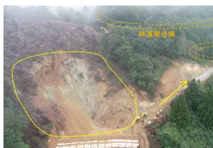
写真5 1号仮設道開設状況
