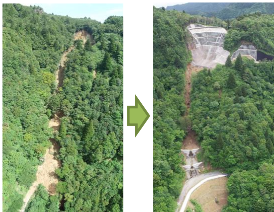
写真 13 復旧状況（全景）
