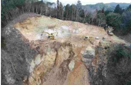
写真7 法面掘削状況
