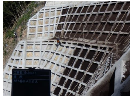
写真 12 植生基材吹付(無種子)状況
