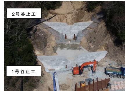
写真10 1号谷止工施工状況
