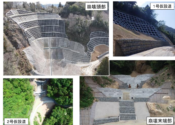
写真 14 復旧状況（近景）
