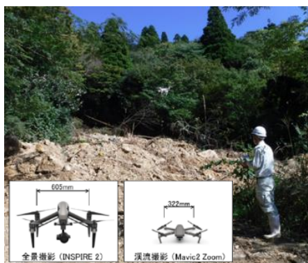
写真3 写真測量の実施状況
