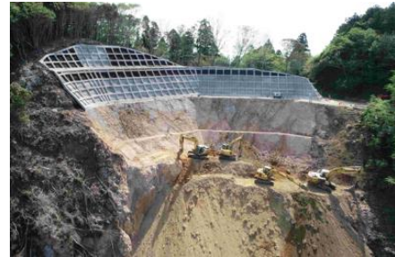
写真8 法柵工(逆巻施工)状況
