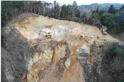
写真7 法面掘削状況
