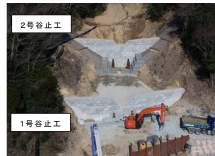
写真10 1号谷止工施工状況
