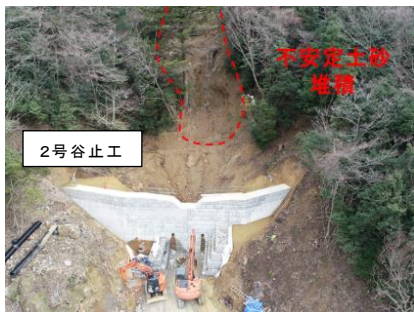
写真9 2号谷止工施工状況
