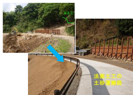
写真6 2号仮設道開設状況
