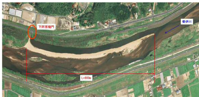
写真-1 斐伊川に設置された砂堰
