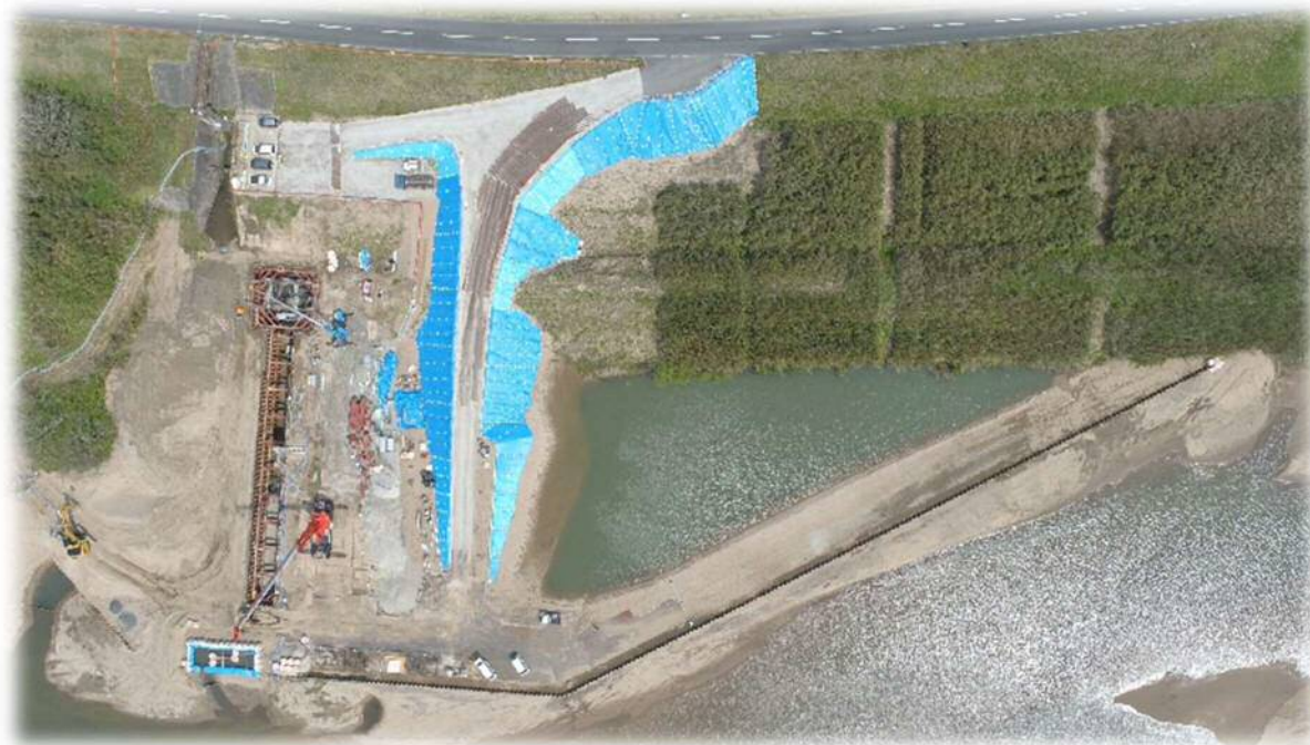
写真-3 河川内工事状況
