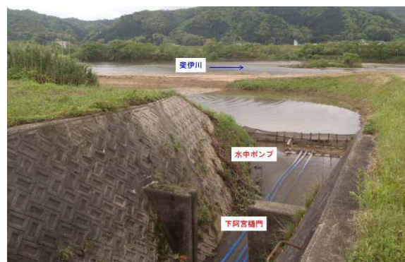
写真-2 下阿宮樋門
