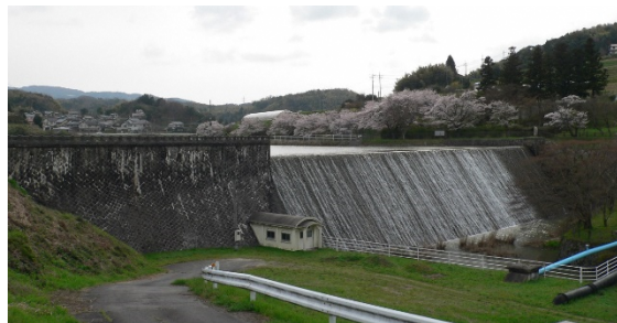
写真-1 千本ダム全景(工事前)
