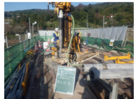
写真－3 削孔状況
