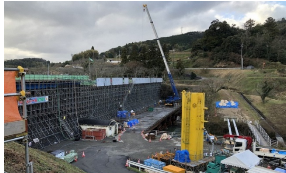
写真－2 施工時全景写真
