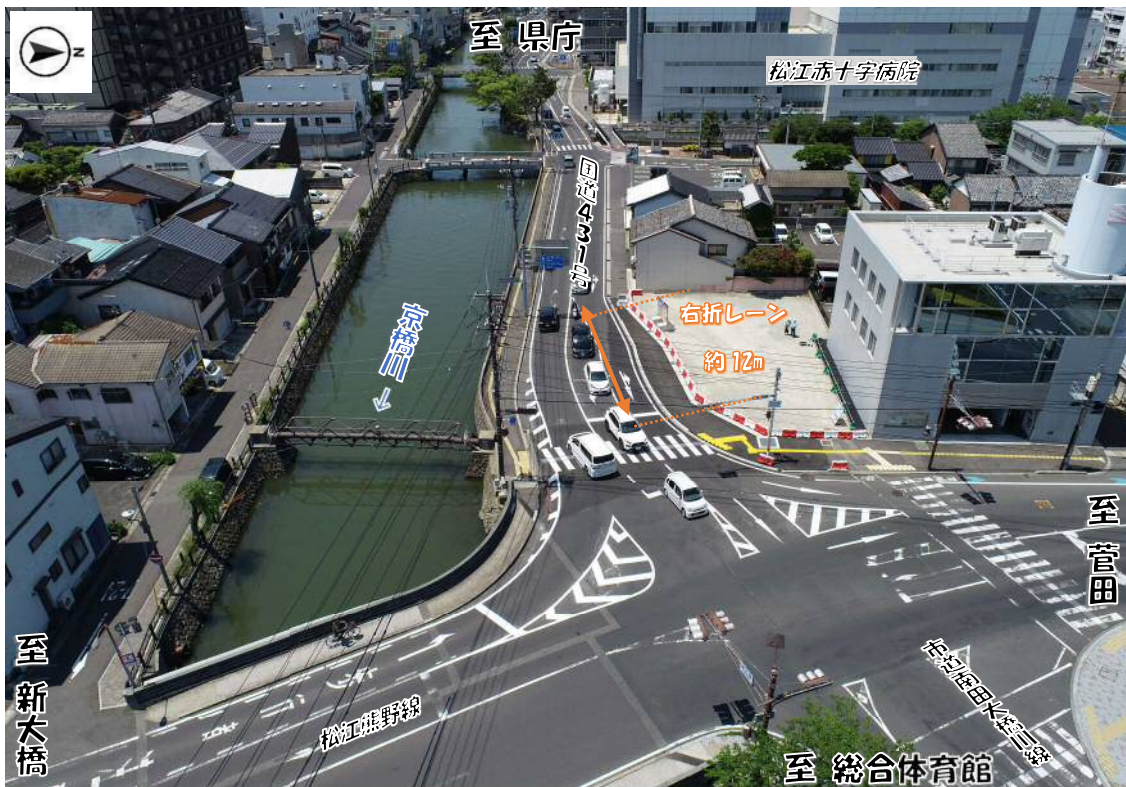
写真-1. 鍛冶橋交差点の全景写真
