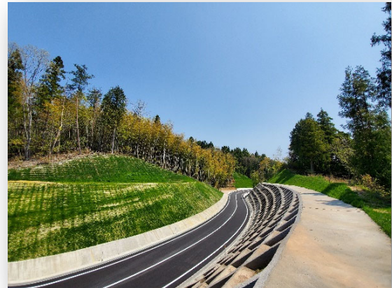
三原古市線 道路改良工工事（川本町）
