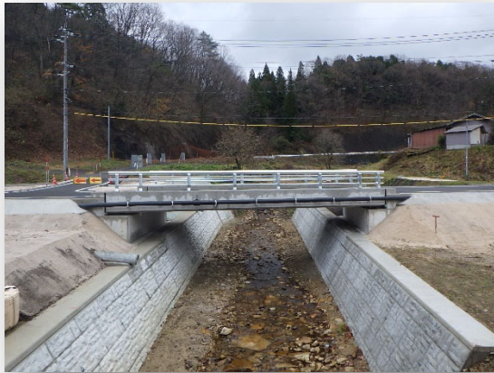
町道松本頓原線 保賀尻橋上部工工事（飯南町）
