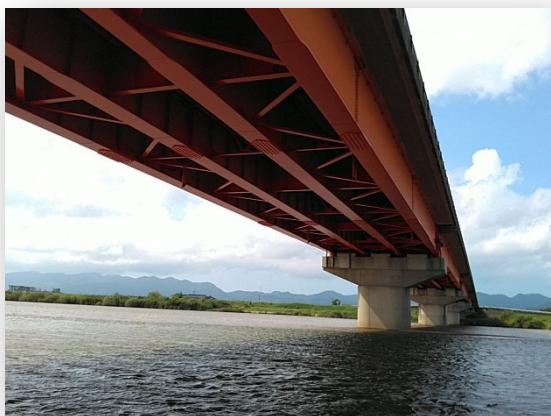
斐川一畑大社線 灘橋 橋梁補修工事 (島根県)
