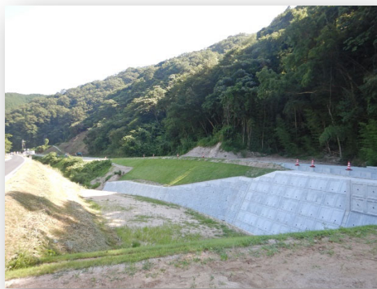
木次直江停車場線 里方三代工区 改築工事 (島根県)
