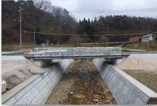
町道松本頓原線 保賀尻橋上部工工事（飯南町）
