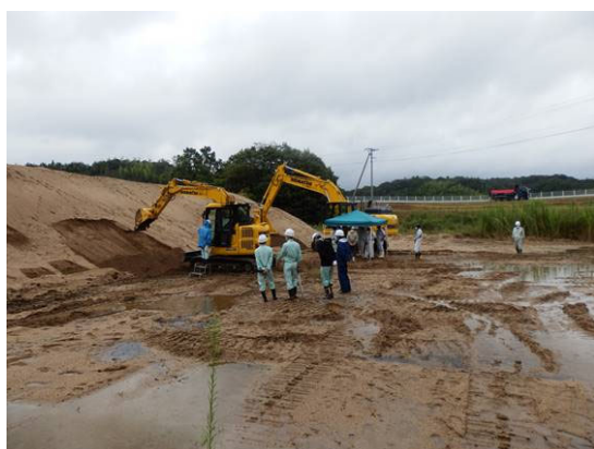
（I C T 施工（バックホウ））
