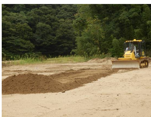
（I C T 施工（ブルドーザ））
