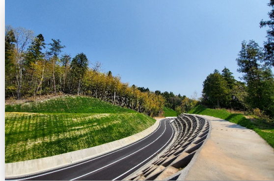
三原古市線 道路改良工事（川本町）
