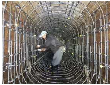
④【補強鉄筋(補強タイプ)】
