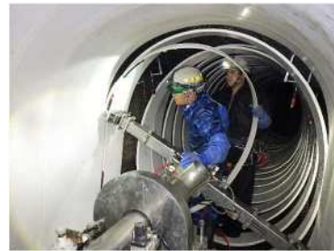
⑥【製管施工状況】
