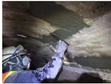
③【下地処理(止水施工状況)】
