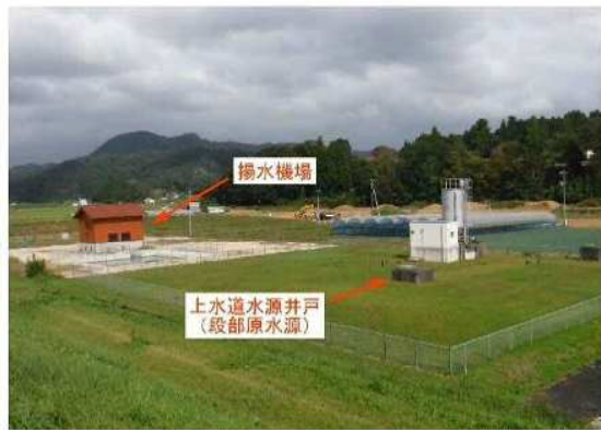
図-2：揚水機場及び水源井戸の写真
