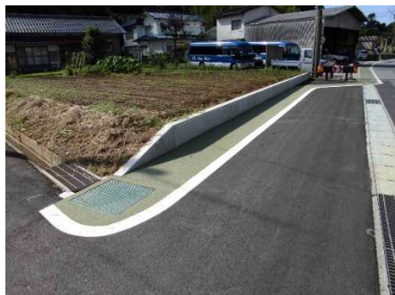
土留擁壁（シキール）施工箇所
