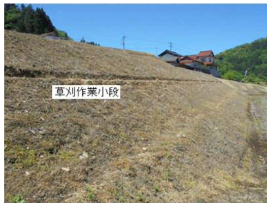
図-10: 作業小段設置、除草作業後
