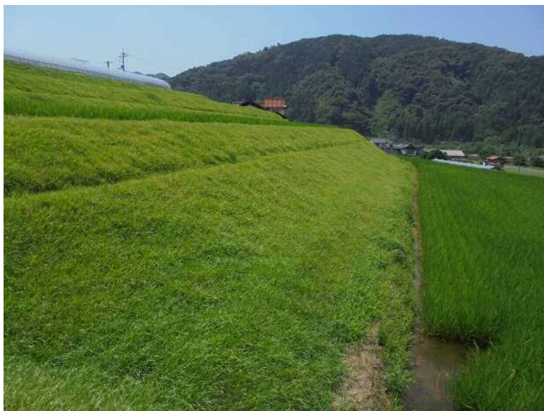
図-13 : 吹き付け後 1 年の法面
