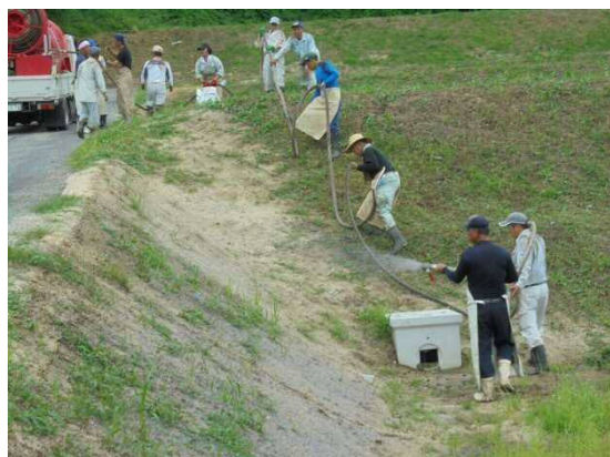
図-11: 吹き付け状況
