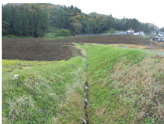
図-7：暗渠排水工施工前
