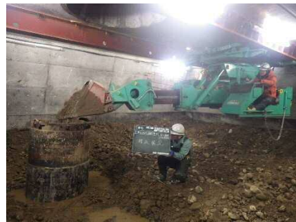
【沈下掘削（有人）】0.14~0.18MPaまで
