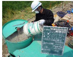
【コンタクトグラウト】
