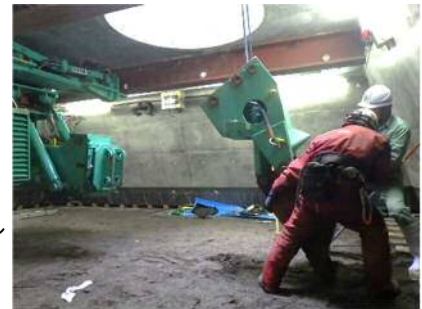
天井走行式ショベル設置状況
