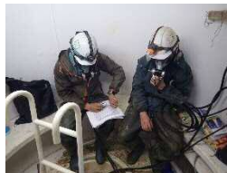
【減圧状況】マンロック内
