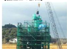
【掘削土の排出】
