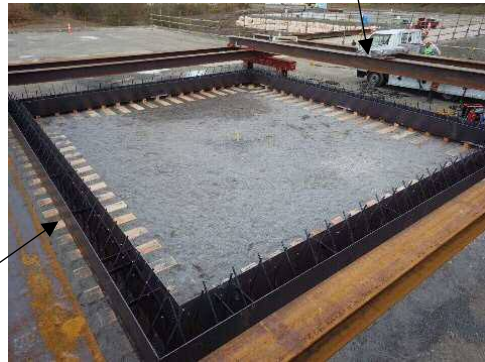
【刃口金物設置完了】
