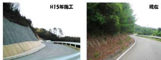
写真3. パネル設置状況
