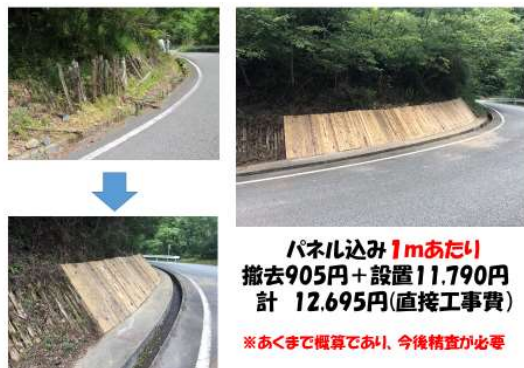
写真6. パネル再設置状況
