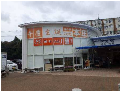
写真-8 案内表示の設置状況
