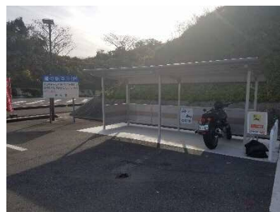
写真-12 駐輪場の設置状況
