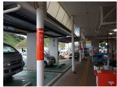
写真-10 案内表示の設置状況
