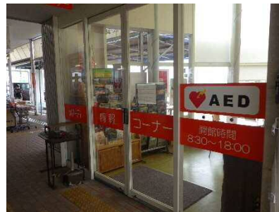
写真-9 案内表示の設置状況
