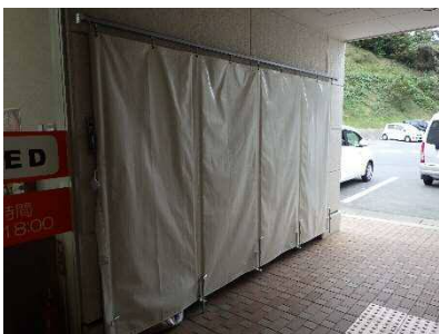
写真-11 目隠しの設置状況
